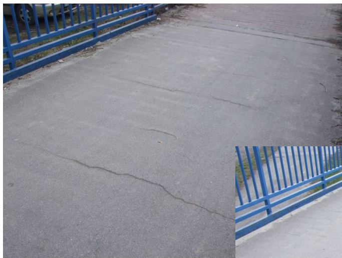
Uszkodzenia nawierzchni bitumicznej kładki w postaci spękań i rys
