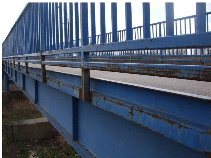
Widoczna uszkodzona powłoka antykorozyjna balustrad i przyległych stalowych elementów
