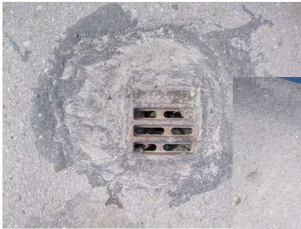
Widoczne wpusty pomostu niedrożne i o zbyt małej powierzchni odprowadzenia wody z nawierzchni
